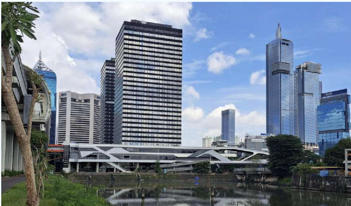
Gambar III.73 Jembatan Penyeberangan Multiguna (JPM) "Serambi Temu" Dukuh Atas
