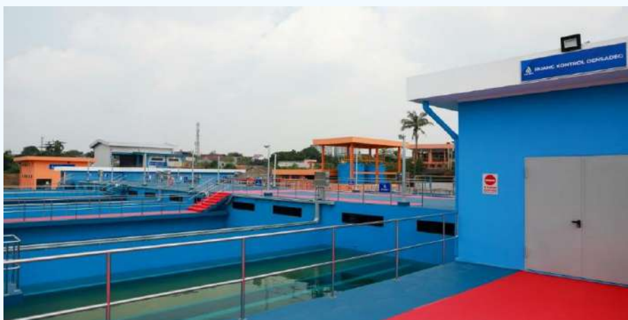
Gambar III.56 Instalasi Pengolahan Air Buaran III
