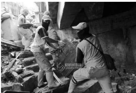
Gambar 8. Pembersihan Kolong Jembatan, Pegangsaan (sumber Sudin Kominfotik Kota Adm Jakpus)
