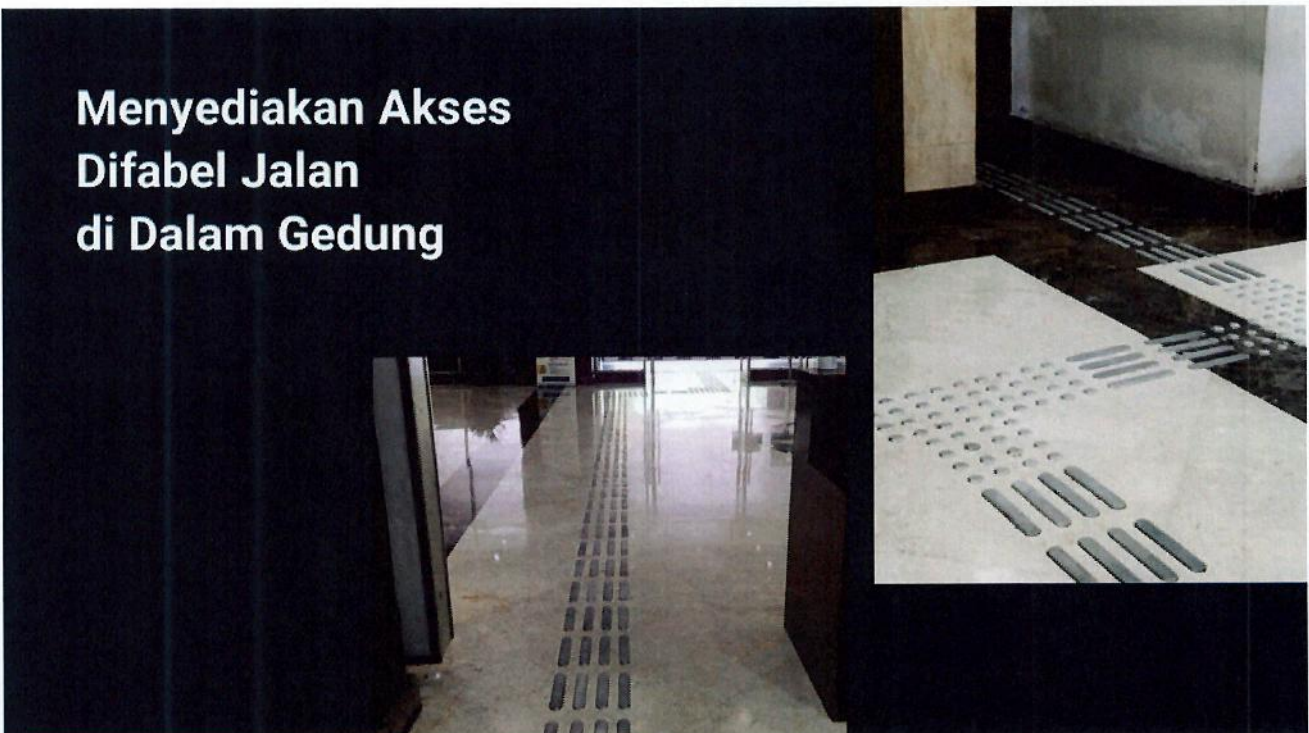
Gambar Jalan Difabel Bagian Dalam Gedung Akses Menuju Ruang Layanan PPID Sektro Administrasi Jakarta Pusat
